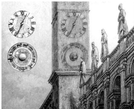
Fig. 3 I due quadranti di Bartolomeo Ferracina nella Torre Bissara raffigurati nella stampa di J.D.Harding e J. Cousen con la ricostruzione in basso del quadrante astronomico
